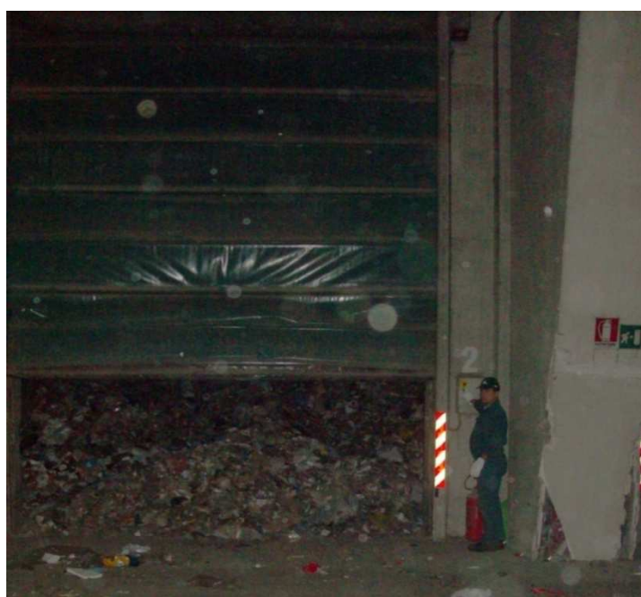
Foto 11. Apertura del portone della biocella (Cella 2) dedicata alla bioessiccazione del rifiuto oggetto della sperimentazione -Foto scattata presso Amiu Spa-Bari
